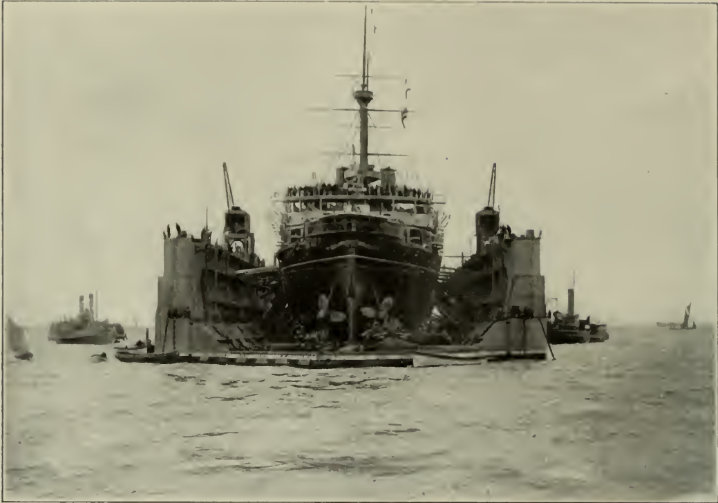
THE BERMUDA FLOATING DOCK LIFTING H. M. S. SANS PAREIL.
